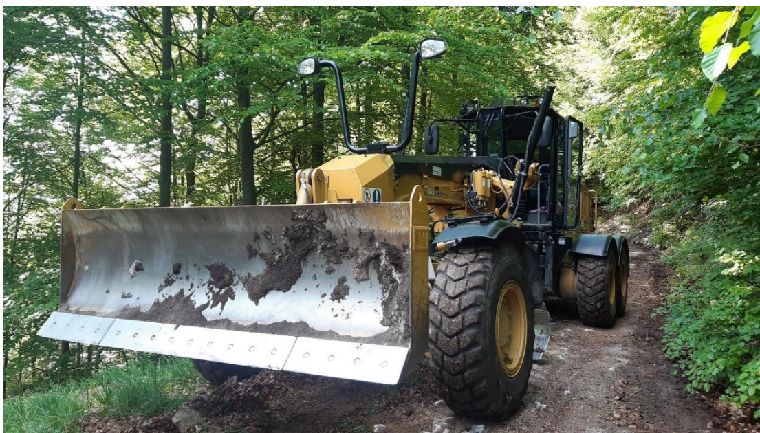
Oprava lesných ciest
