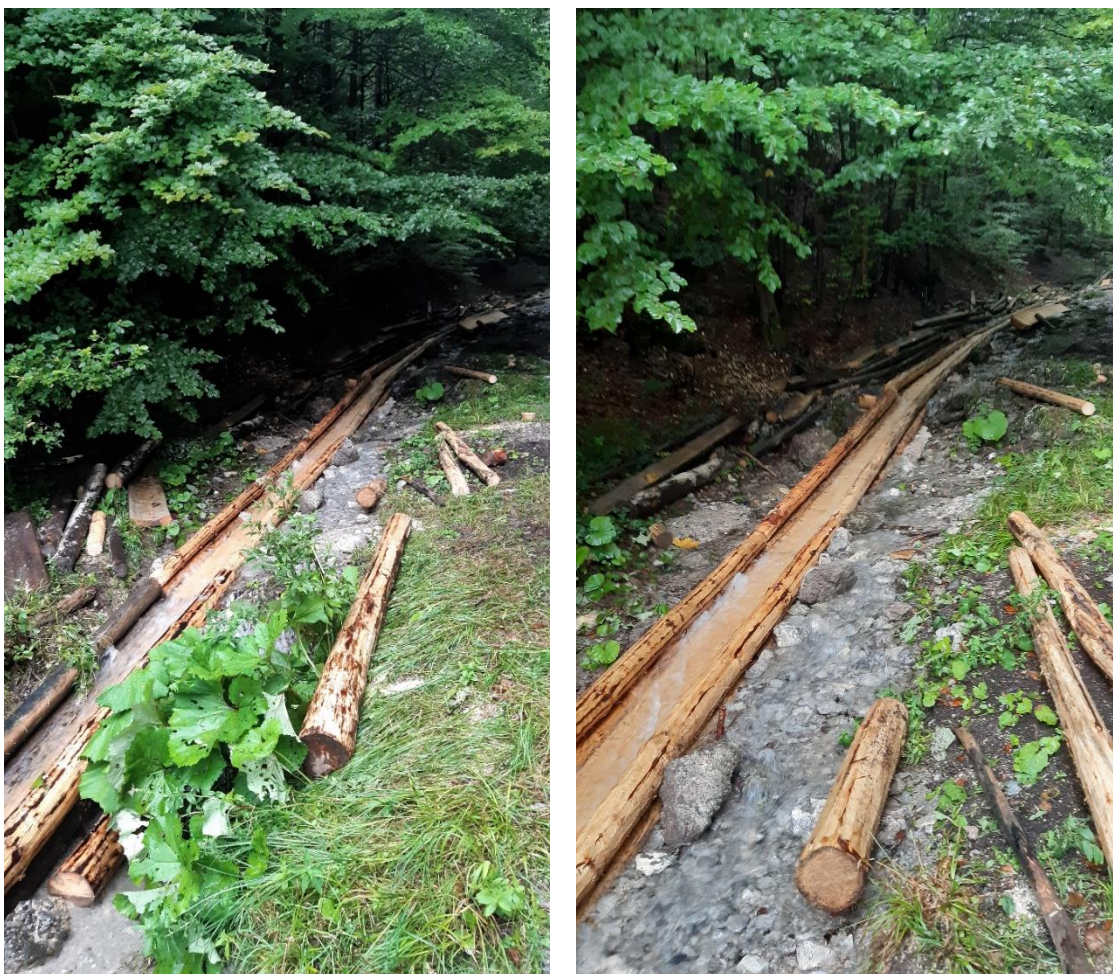
Oprava vodného žľabu Rakytovo
